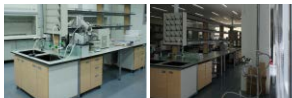
세안장치와 샤워장치 설치 모습
